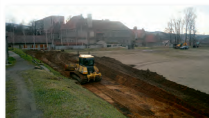
První práce na novém hřišti s umělým povrchem
