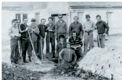
Brigáda na stavbě hasičské zbrojnice - 1984
